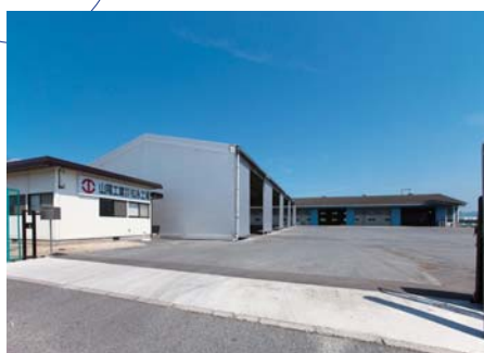
所在地:福山市南松永町4丁目11-43 敷地:6,300㎡
